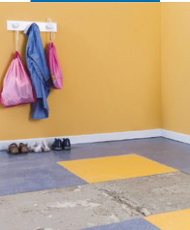
Remoción de una porción del acabado en piso resiliente en el área a ser reparada
