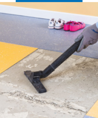
Remoción de polvo con una aspiradora
