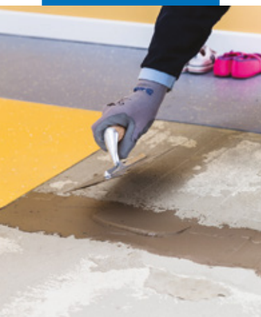
Reparación de una porción del soporte
