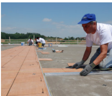
Colocación de cerámica con Kerabond + Isolastic
