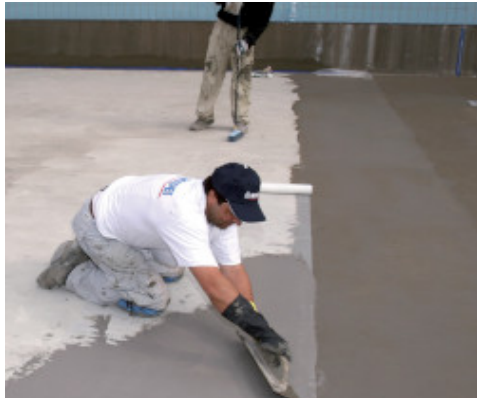
Impermeabilización de una piscina con Mapelastic
