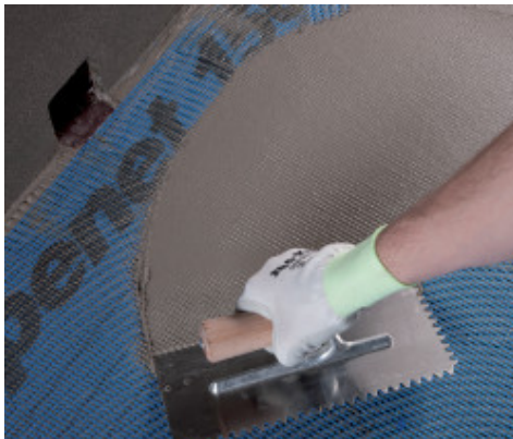
Aplicación de Mapelastic sobre Mapenet 150
