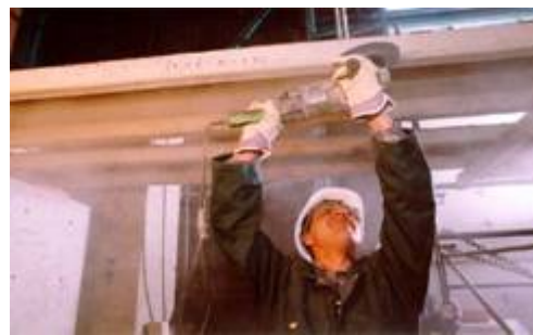
Fig. 4.2. Preparación soporte: limpieza con radial
