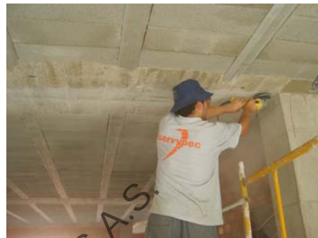
Fig. 4.4. Preparación soporte: lijadora con disco de diamante
