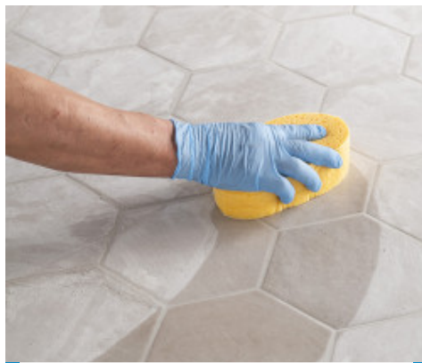
Limpieza y acabado de las juntas con esponja dura de celulosa.
