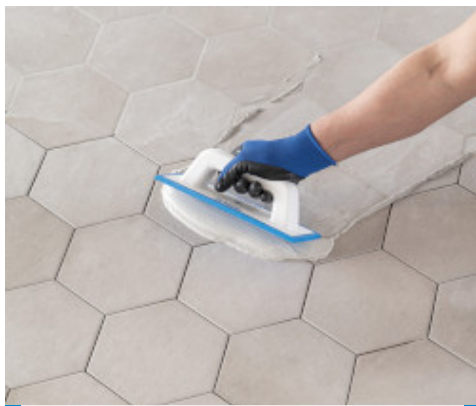
Aplicación de Keracolor FF con la llana de goma MAPEI
