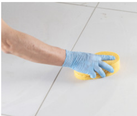
Limpieza y terminación de juntas con esponja de celulosa dura
