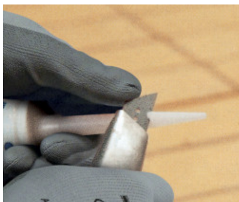
Cortar la boquilla según las dimensiones de la junta
