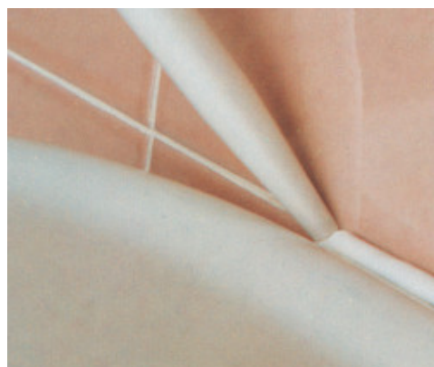
Sellado de elementos sanitarios
