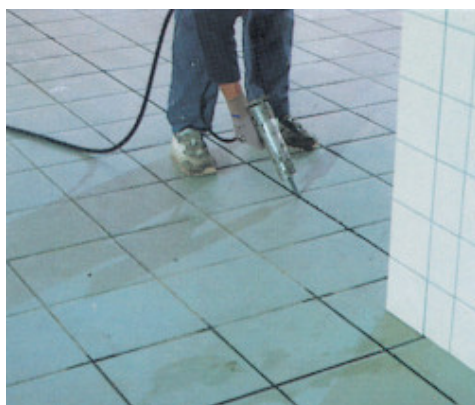
Sellado de un piso cerámico con Mapesil AC
