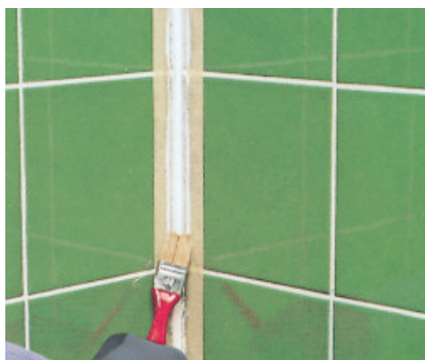
Alisado de la junta con agua jabonosa y una pequeña brocha
