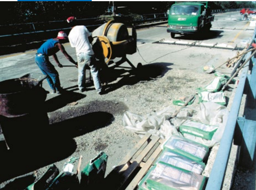
Reconstrucción de juntas en vías
