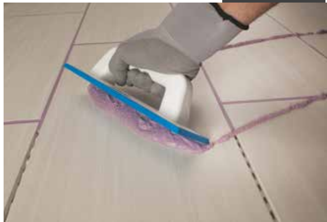
Aplicación de Kerapoxy CQ con llana Mapei
