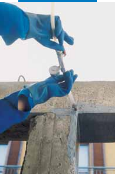
Aplacado metálico con Adesilex PG1
