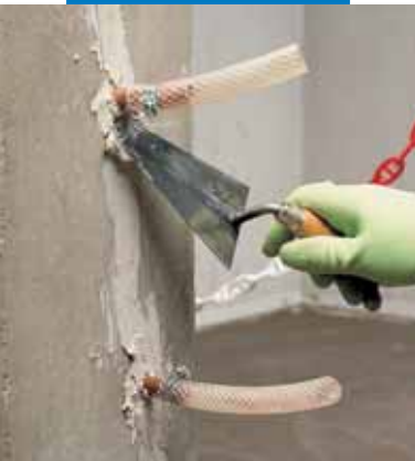
Fijación de la boquilla de inyección y sellado de la fisura antes de proceder a la consolidación estructural
