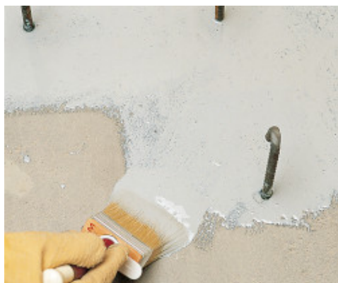
Aplicación de Eporip con brocha para puente de adherencia
